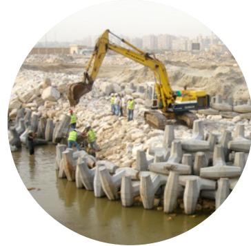
أعمال حماية الشواطئ.
